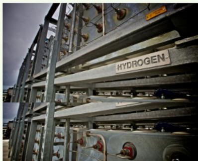
Cilindros de almacenamiento de hidrógeno
