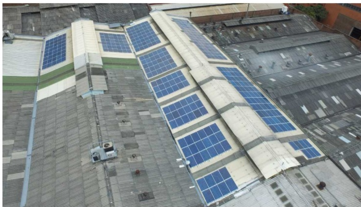
En Antioquia, Norte de Santander, Costa Atlántica, Bolívar, Cundinamarca y Sucre se instalaron 3.067 paneles solares para la generación de energía. - Foto: Cortesía BOSI.
