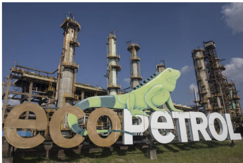
Ecopetrol Señalización en la refinería de Ecopetrol en Barrancabermeja, Colombia, el martes 15 de febrero de 2022. (Ivan Valencia/Bloomberg)
