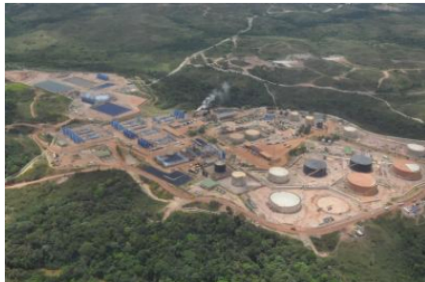
La producción de hidrocarburos en Colombia se ve afectada por problemas eléctricos (Foto: Petroguía )
