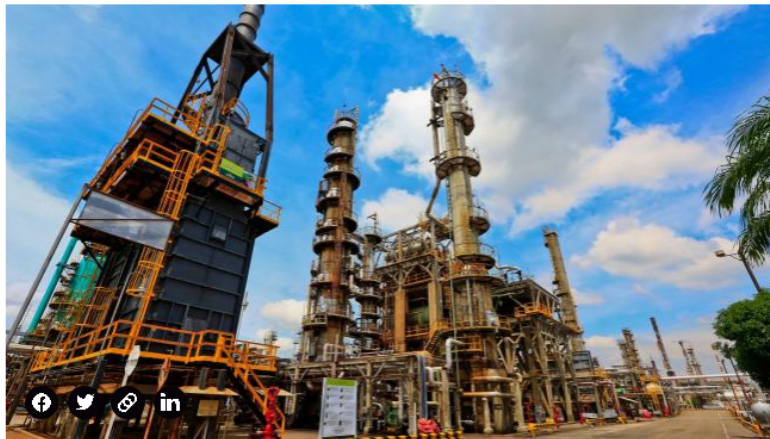
Refinería de Barrancabermeja en la actualidad.
