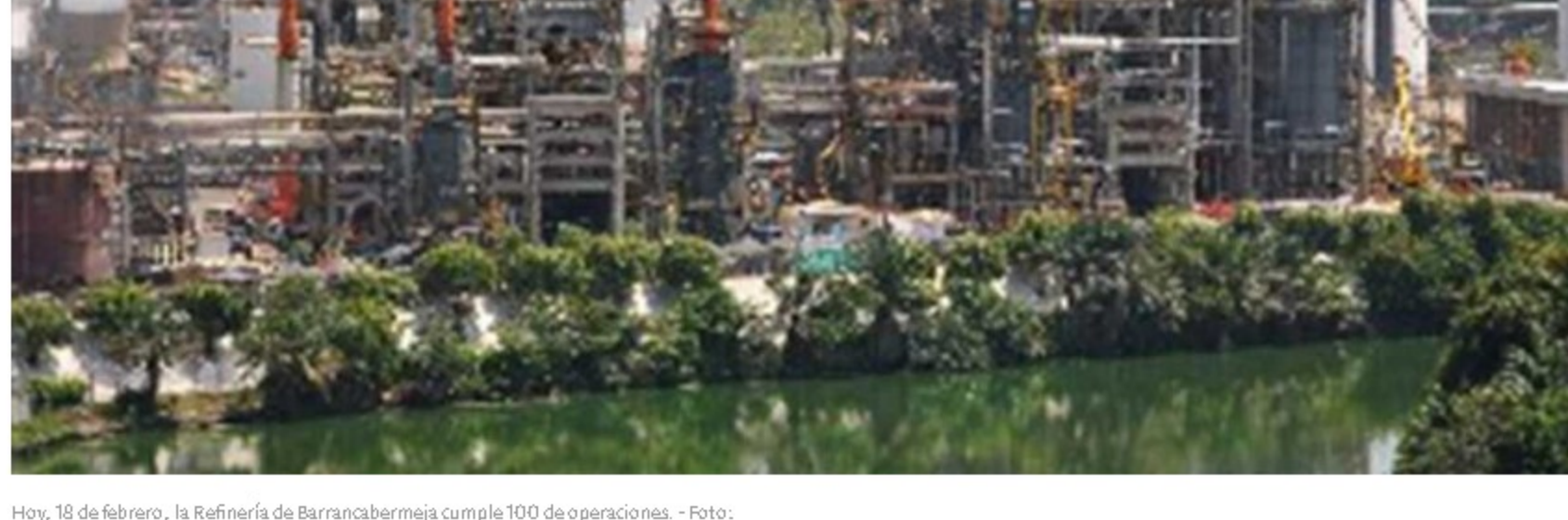
Hoy, 18 de febrero, la Refinería de Barrancabermeja cumple 100 de operaciones. - Foto:
