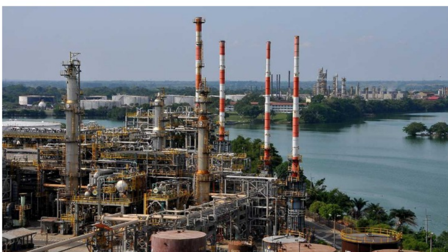
construirá un parque solar de 15 megavatios en Barrancabermeja. Foto: - Foto: Foto:
