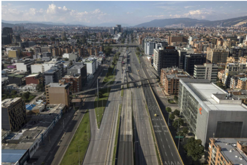
Bogotá, Colombia Los vehículos circulan por carreteras casi desiertas en esta fotografía aérea tomada en Bogotá, Colombia, el domingo 22 de marzo de 2020. (Ivan Valencia/Bloomberg)
