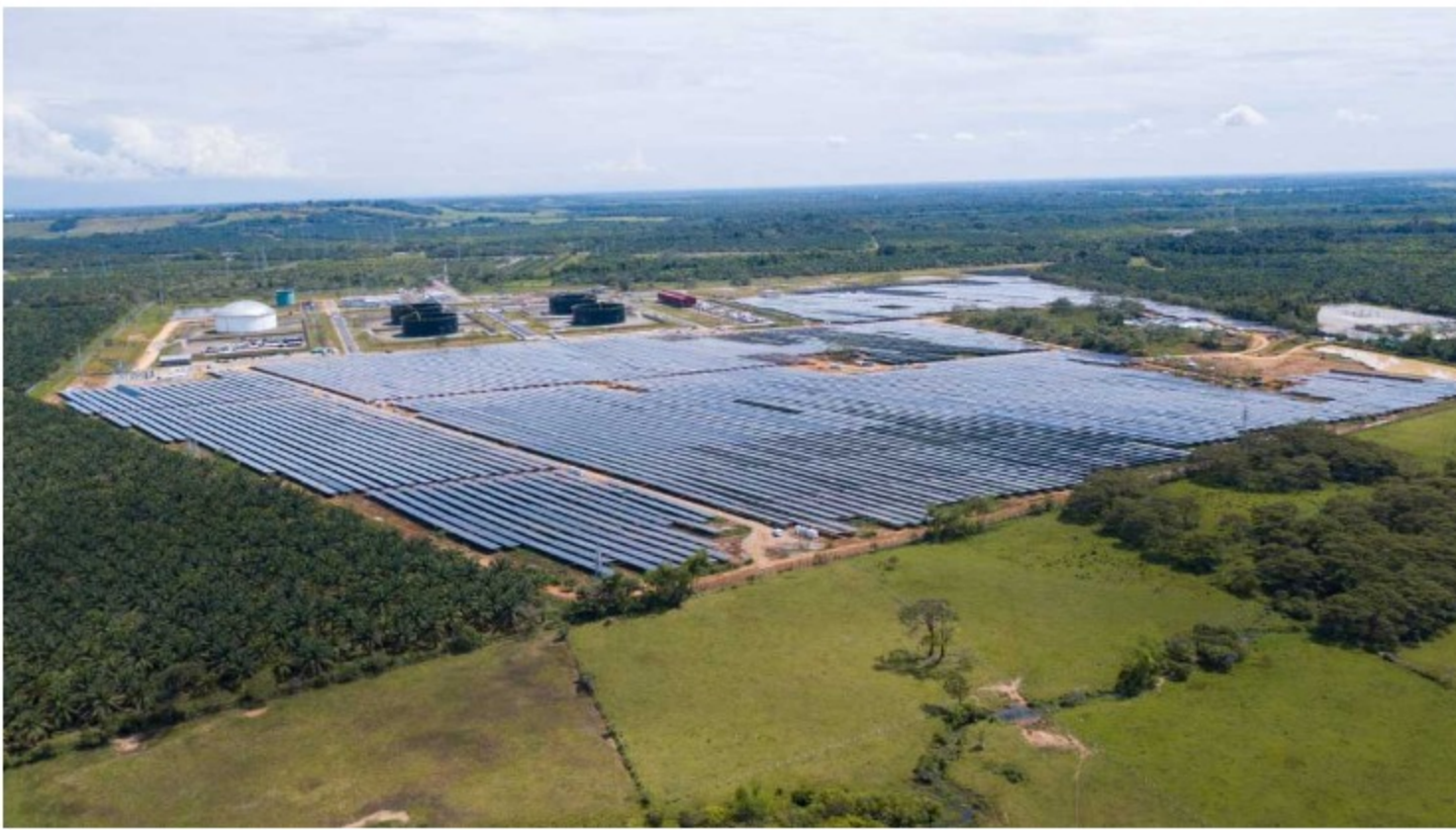
Parque Solar San Fernando de 61 MWp - Foto: Cortesía: Ministerio de Minas y Energía
