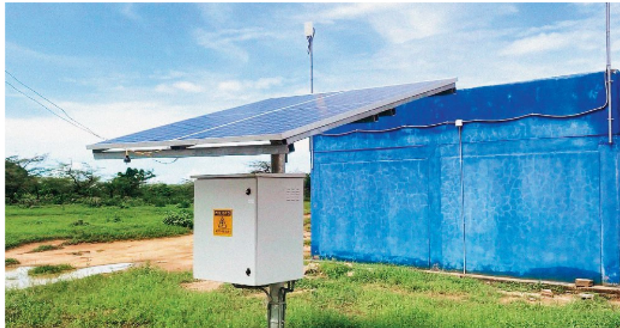
Un poco más de 1.000 megavatios de generación proyectada en las primeras obras de La Guajira están retrasadas, al igual que la línea Colectora. – Foto: ministerio de minas
