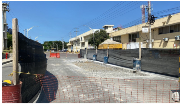
Obras de reconstrucción en la vía 40. - Foto: Semana
