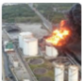
Incendio en la Vía 40: llamas se mantienen en tanques de Bravo Petroleum
