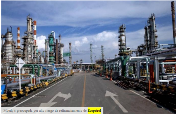
Moody's preocupada por alto riesgo de refinanciamiento de Ecopetrol
