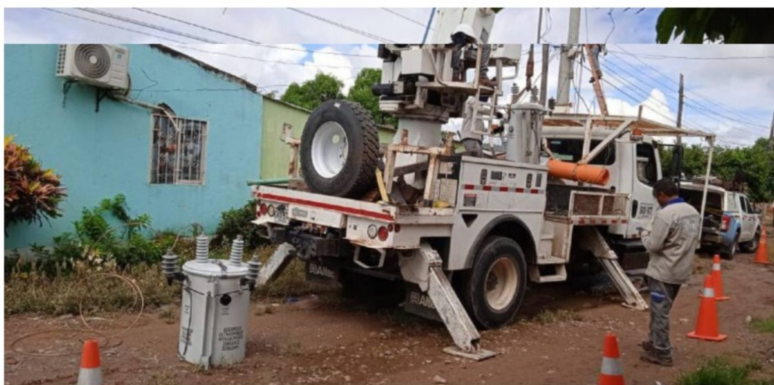
Trabajos en Bolívar / Afinia
