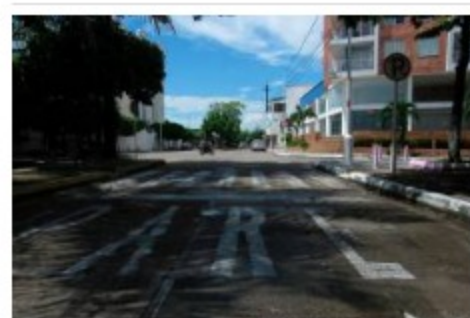
Confusa señal de pare en el barrio La Libertad
