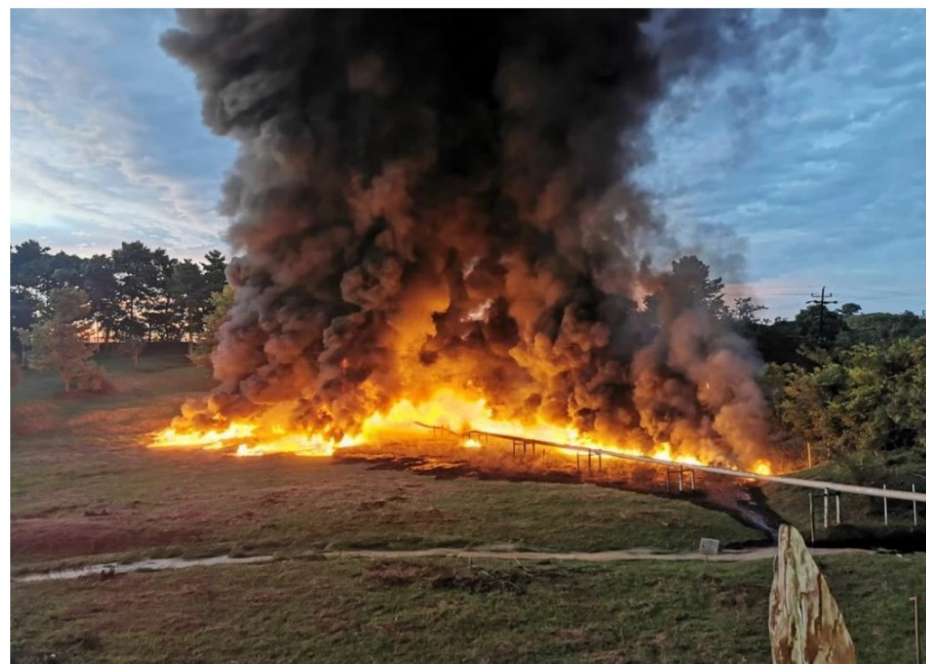
BLU Radio. Explosión oleoducto en Barrancabermeja / Foto: Ecopetrol
