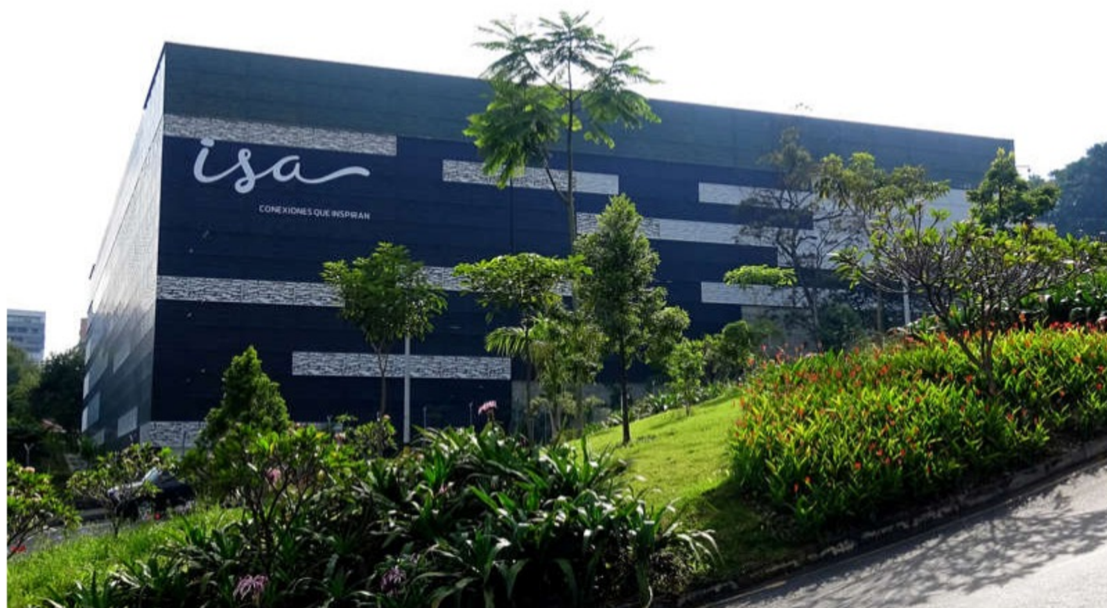
© Reuters/LUIS JAIME ACOSTA Foto de archivo. Vista general del edificio de ISA en la ciudad de Medellín
