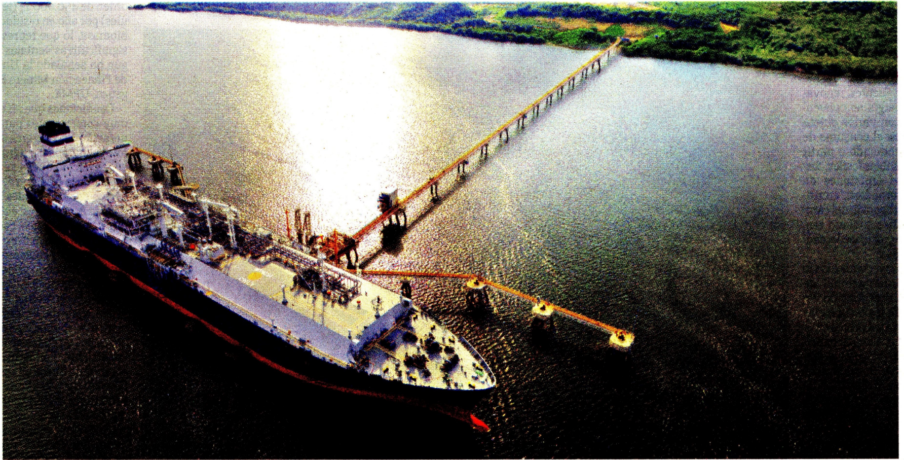
La terminal de regasificación de SPEC LNG ofrece ventajas competitivas para expandirse de forma ágil y eficiente, para suplir el déficit de gas proyectado por la UPME /Fotos: Cortesía Promigas.
