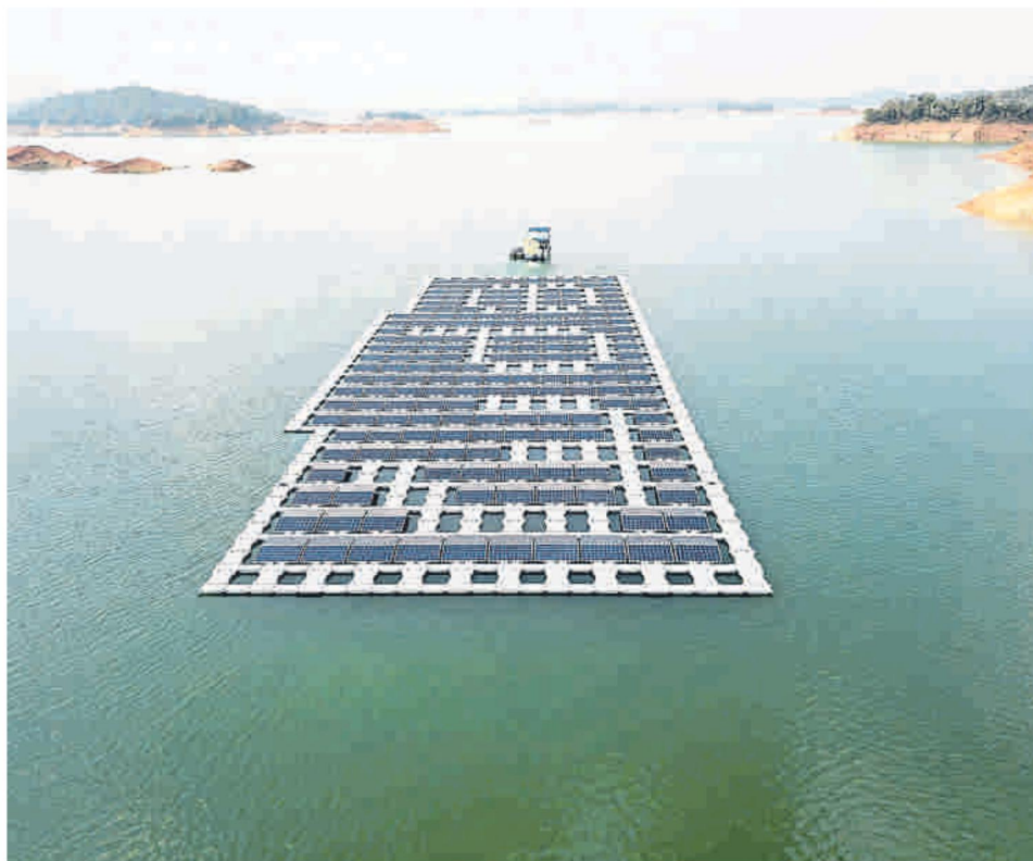
La electricidad producida en los paneles es del sol y la radiación por reflejo desde el agua. EPM
