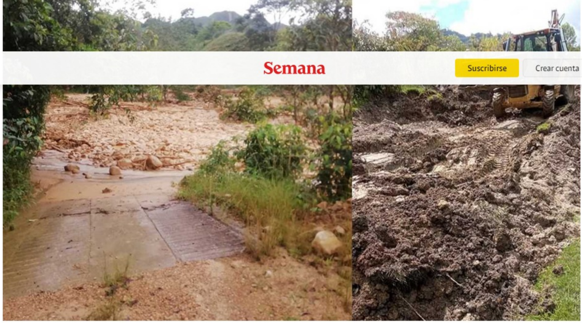
Las lluvias de las últimas semanas en Ubalá, Cundinamarca, generaron graves emergencias; dejando a cerca de 130 familias incomunicadas y bloqueadas las vías de acceso de cerca de 550 campesinos de la región. - Foto: Revista Semana
