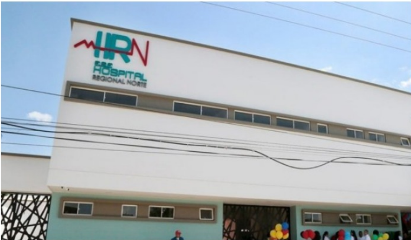
La inversión permitirá adquirir y poner en funcionamiento 78 equipos médicos, entre aspiradoras de secreciones, bombas de infusión, válvulas para video laringoscopia, monitores de signos vitales, rayos X y cápsulas portátiles de asilamiento.. / Foto: Archivo
