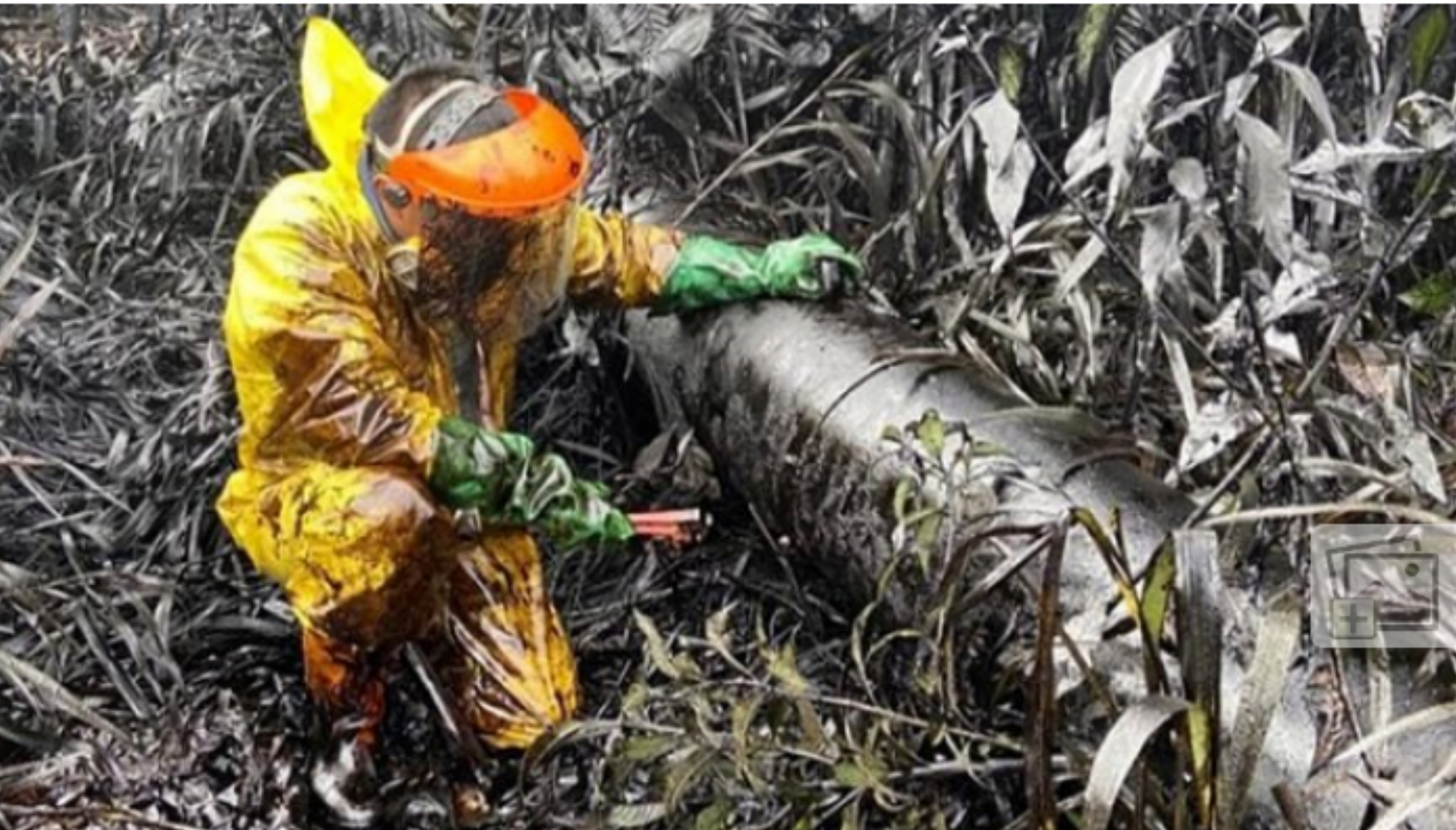
El uso de válvulas para robar hidrocarburos es peligroso para el medio ambiente. En el sistema Caño Limón-Coveñas se han detectado 27 válvulas ilícitas, la mayoría en Tibú y El Tarra, Norte de Santander. / Foto: Ecopetrol
