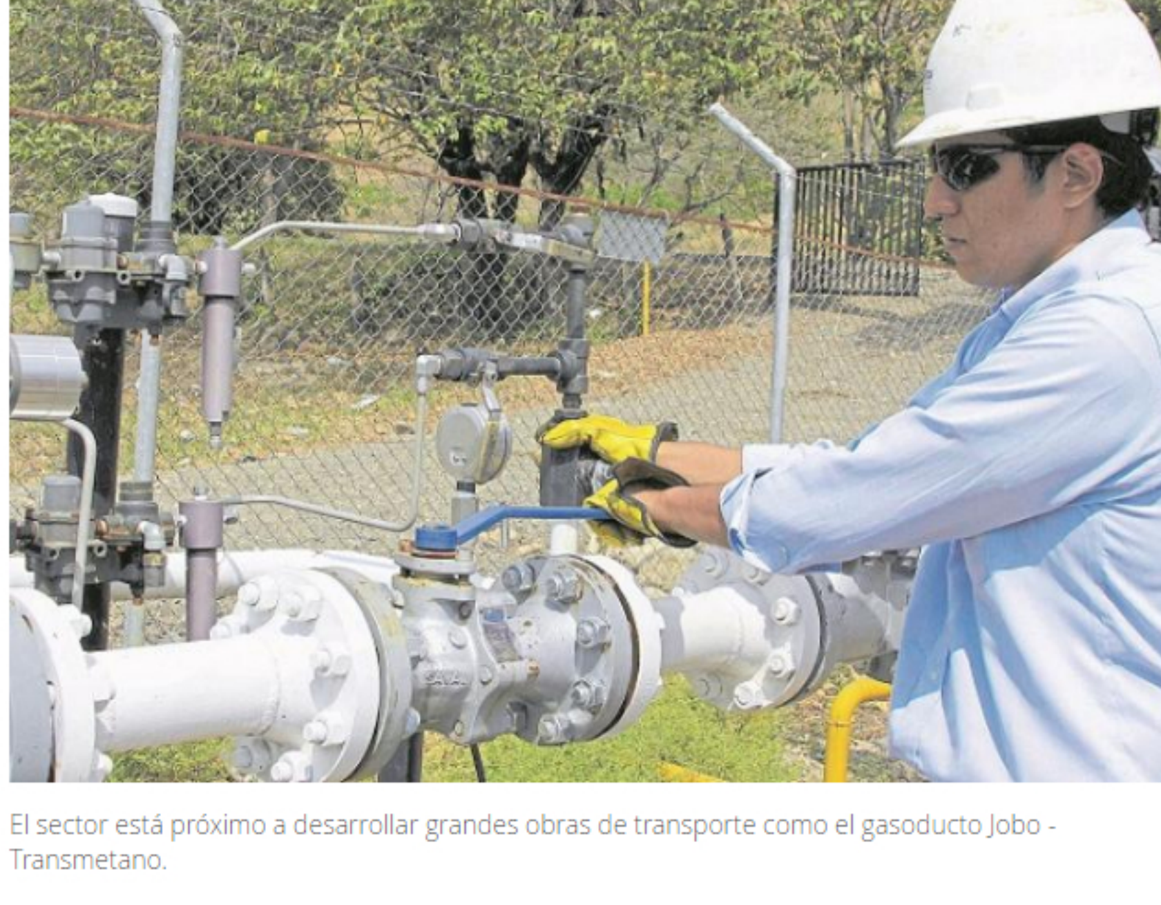
El sector está próximo a desarrollar grandes obras de transporte como el gasoducto Jobo - Transmetano.
