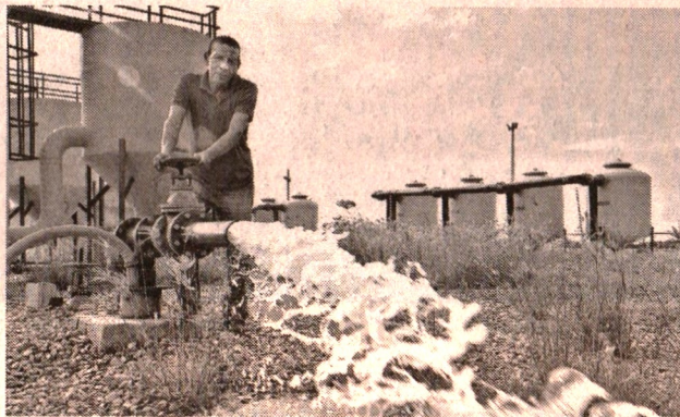
Los acueductos municipales, una de las obras de regalías. CEET
