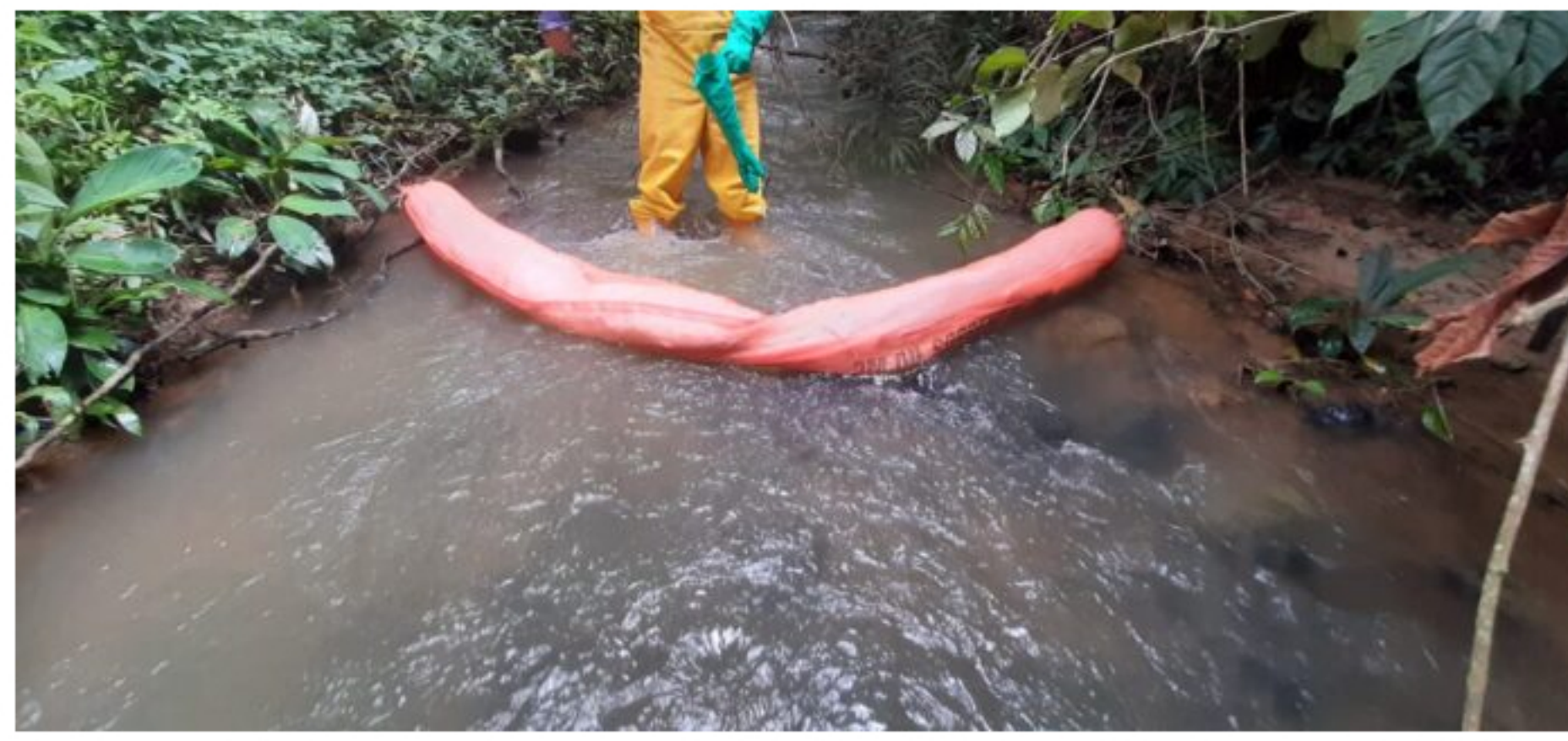
Los operarios han instalado elementos para evitar que la mancha se propague. Foto Cortesía Ecopetrol
