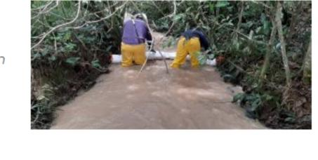
hídrico hasta el río Orotoy para evitar la dispersión del fluido, 19 barreras mecánicas de 7 y 14 metros respectivamente, y 52 bultos en sitio de material absorbente del diluyente.
