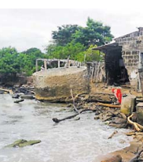
La zona de Moñitos afectada por erosión.
