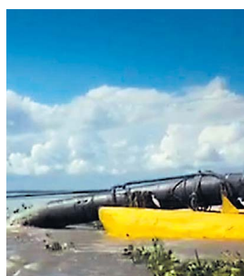
La draga en los trabajos de extracción de sedimento.
