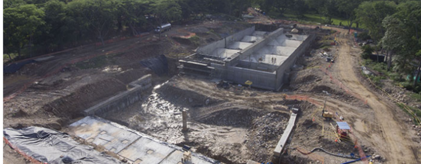
El desarenador es una estructura que se construye para retener la arena que traerán las aguas captadas de la pileta de sellos de Termotasajero, transportadas desde la cámara de salida por la tubería de aducción. (Foto: Juan Pablo Cohen).
