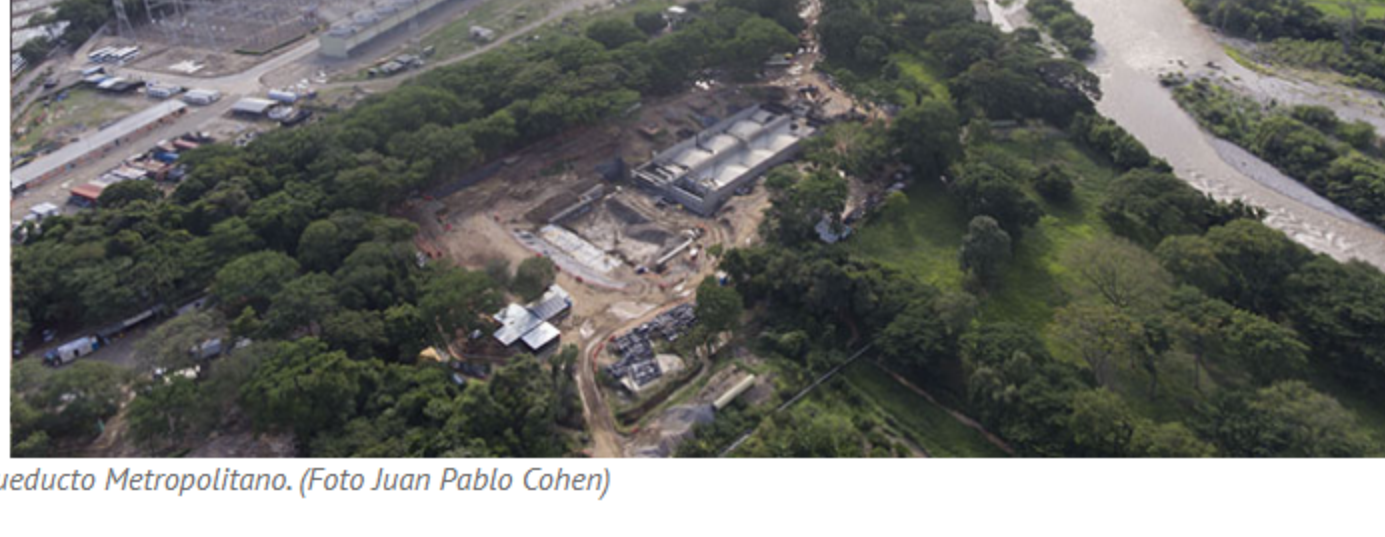
Así se ve la obra del Acueducto Metropolitano. (Foto Juan Pablo Cohen)
