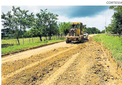
Maquinaria en trabajos de una obra vial.
