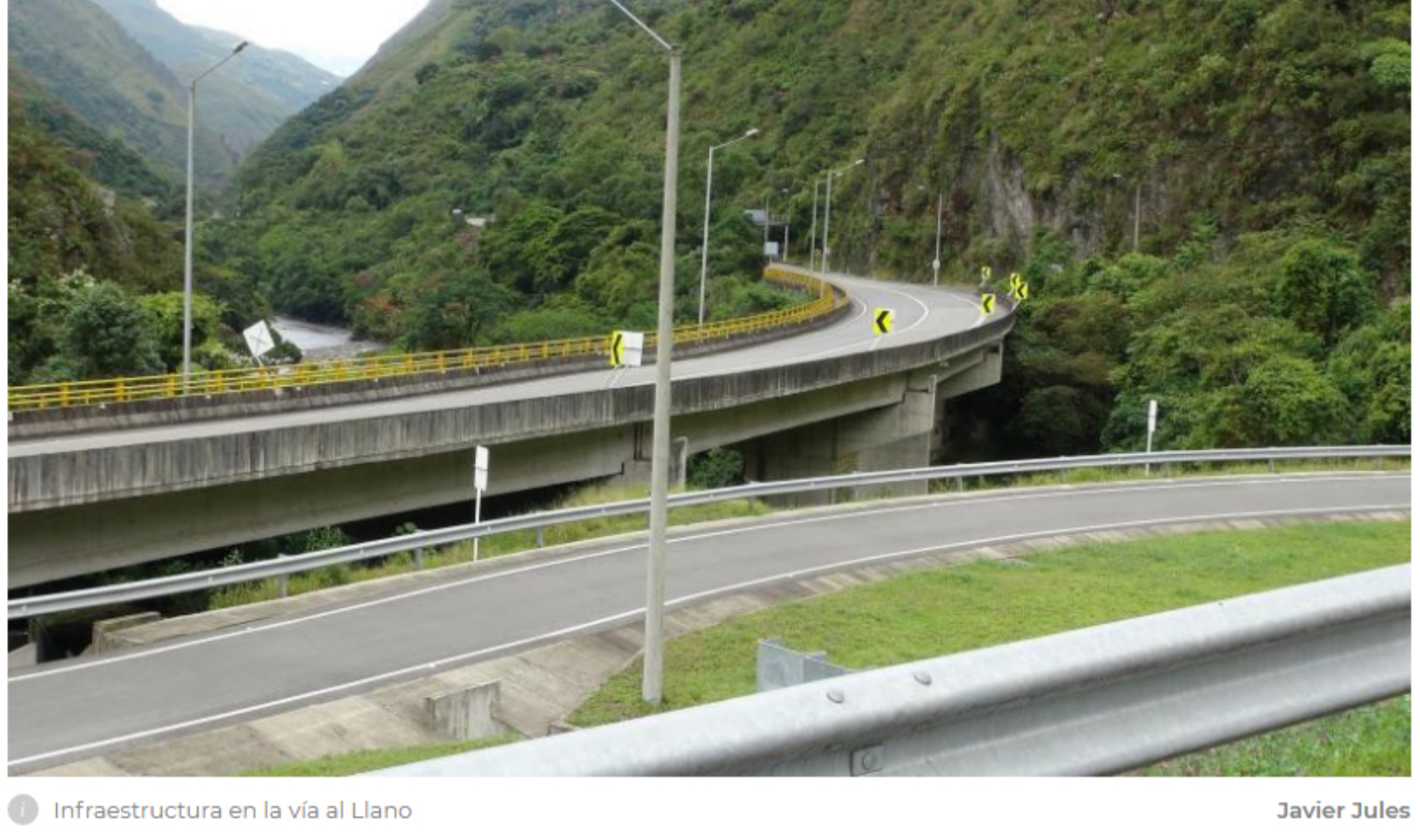
Infraestructura en la vía al Llano
