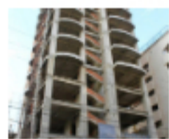
'Salvavidas' para la construcción en Cartagena
