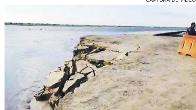
Este es el nuevo tramo que arrancó de tajo el río.
