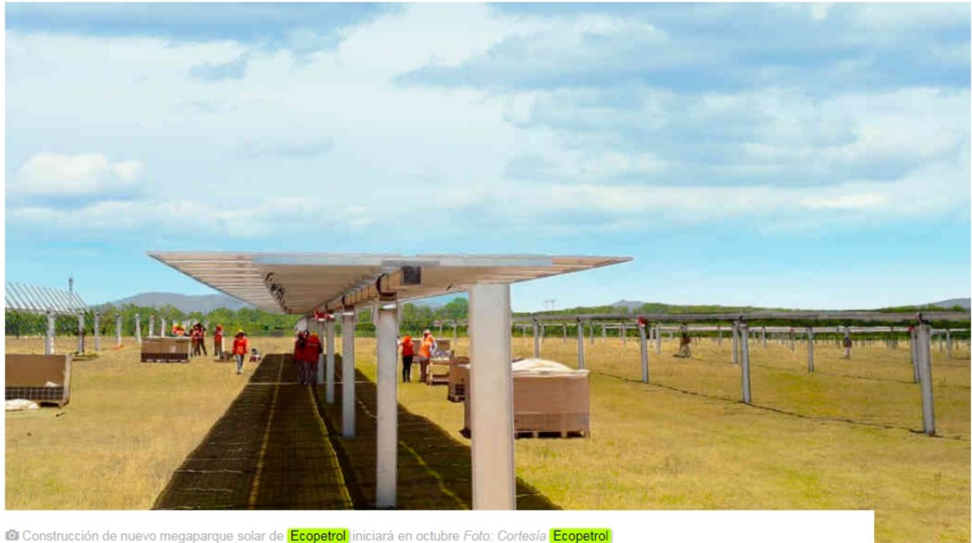
📷 Construcción de nuevo megaparque solar de Ecopetrol iniciará en octubre Foto: Cortesía Ecopetrol
