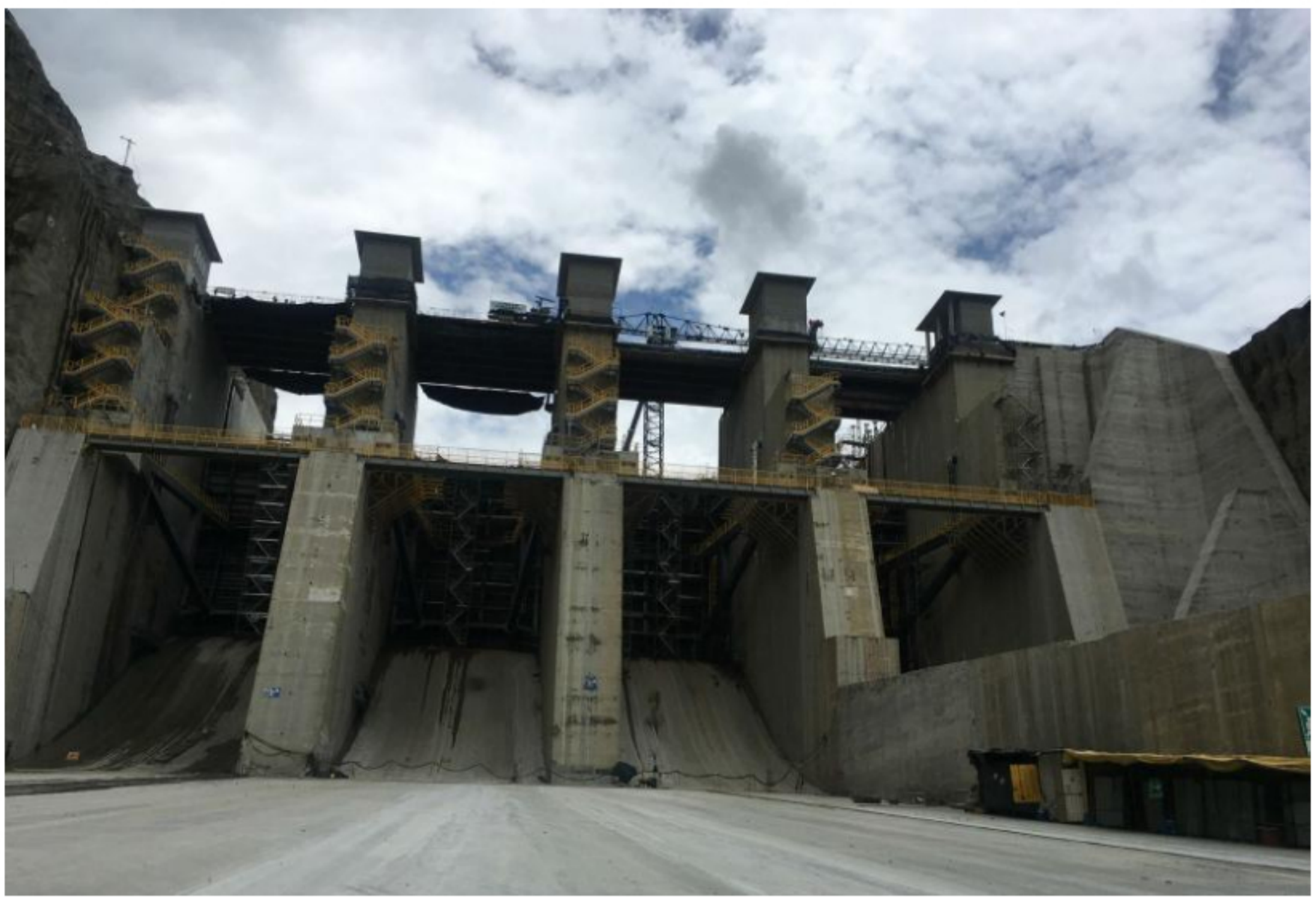
Vertedero de Hidroituango.
