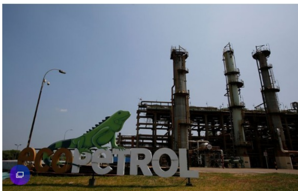
Foto de archivo. Panorámica de la refinería de Ecopetrol en Barrancabermeja
