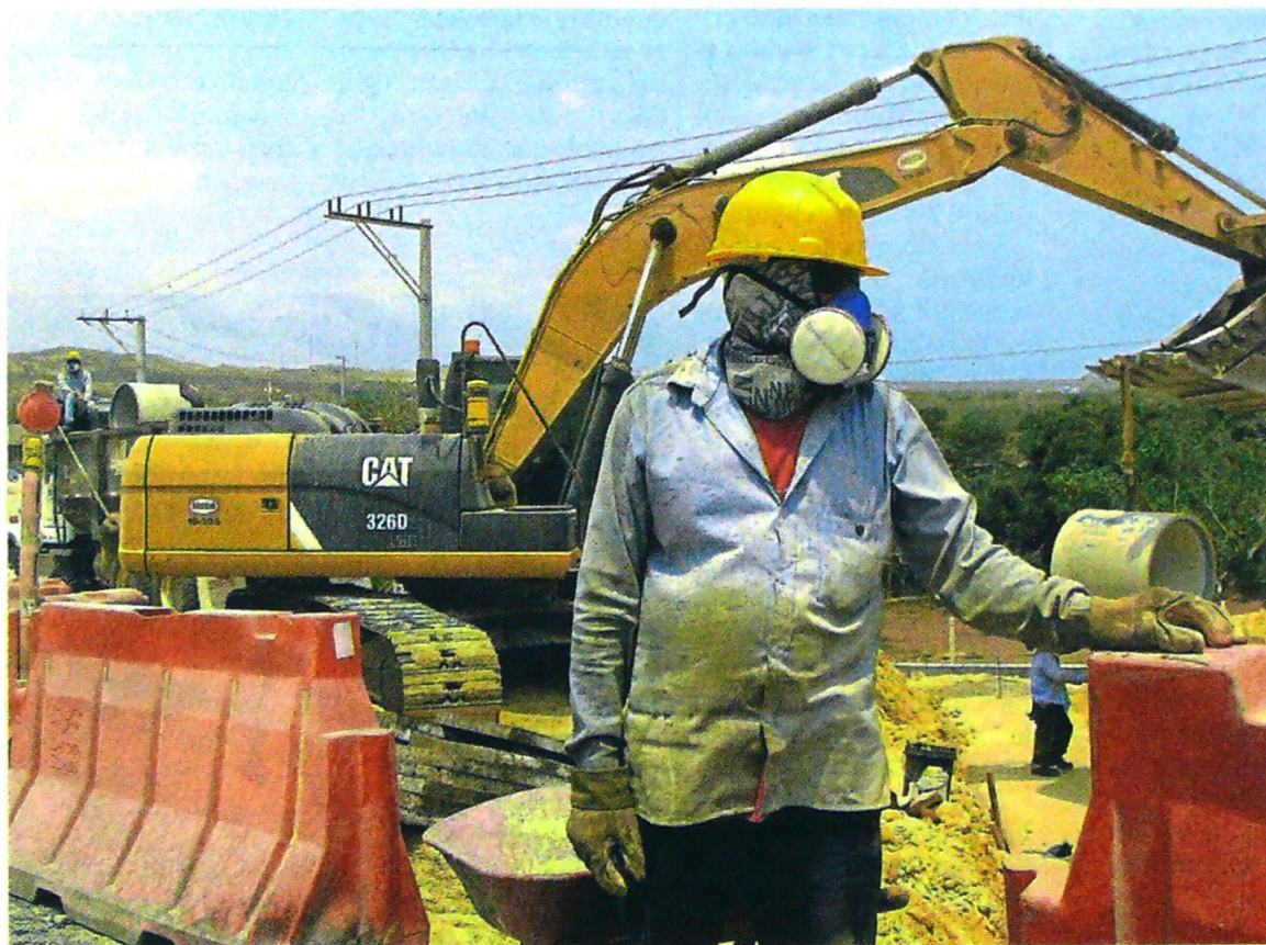
En el sector de la construcción ya hay operaciones reabiertas en 19 departamentos del país. Archivo.
