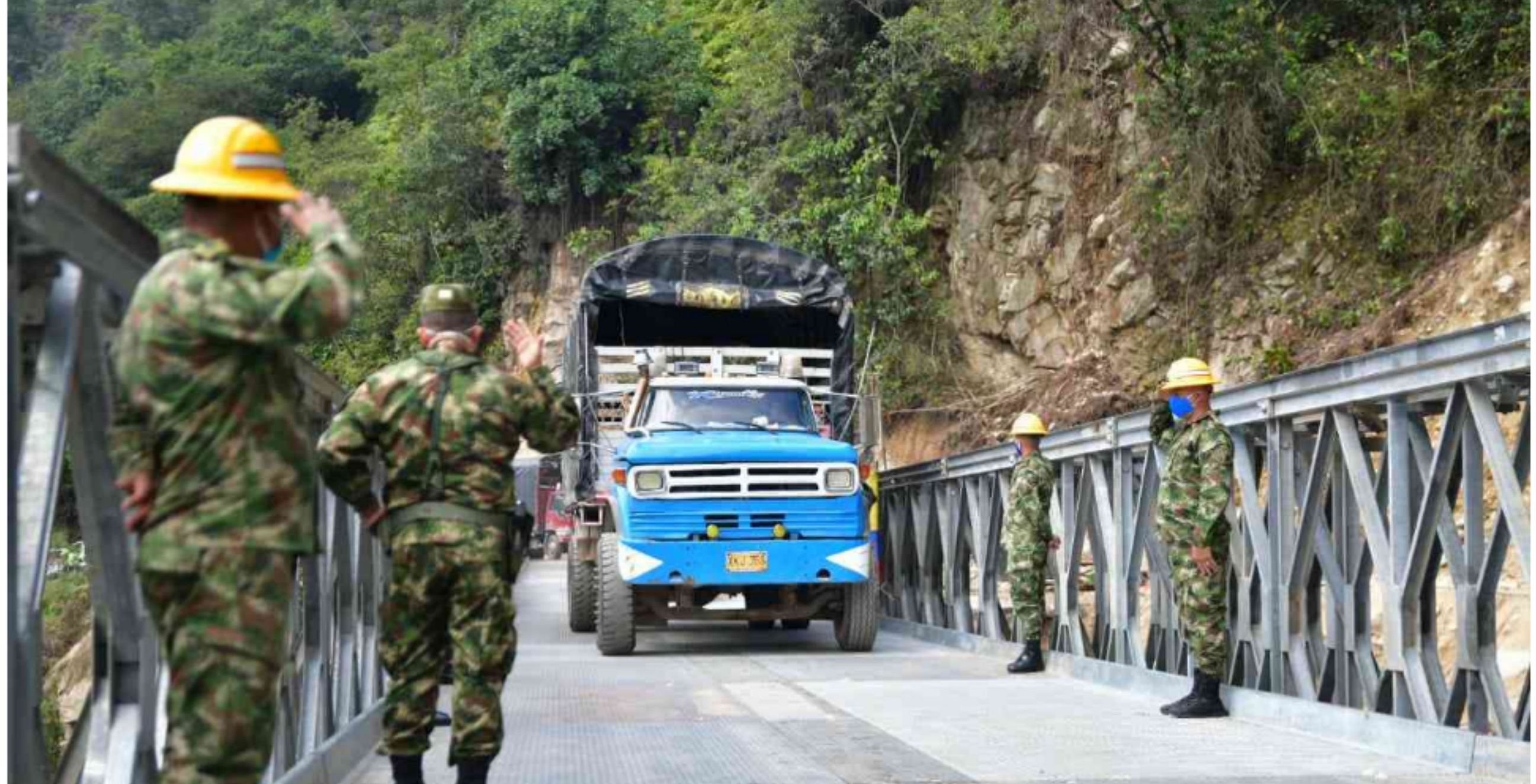
Vía Curos-Málaga ya tiene paso provisional por puente del Ejército Foto: Gobernación de Santander
