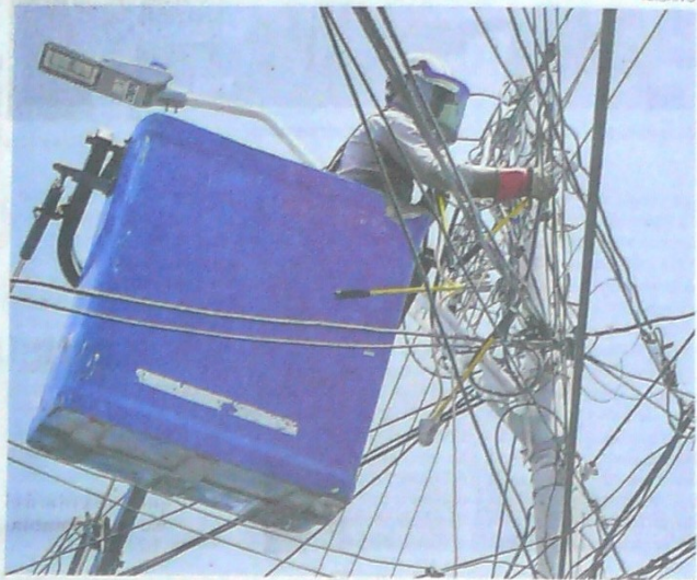
Un contratista de Electricaribe realiza trabajos de mantenimiento de redes.
