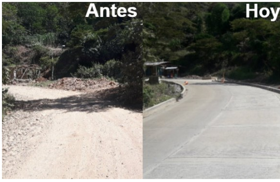
Aspecto de la vía veredal reconstruida por Epsa en el Cauca. Foto Cortesía Celsia
