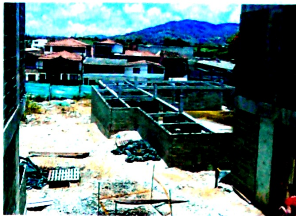
Así están las obras en el colegio Fray Julio Tobón en El Carmen de Viboral (Antioquia). ARCHIVO PARTICULAR
