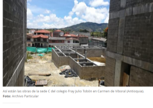
Así están las obras de la sede C del colegio Fray Julio Tobón en Carmen de Viboral (Antioquia). Foto: Archivo Particular
