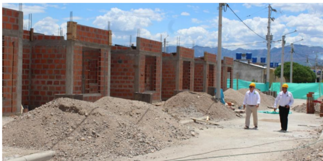
Aipe es uno de los municipios beneficiados. Allí se construyen 199 viviendas de interés prioritario en la urbanización Las Marías, fase II. Foto: Cortesía
