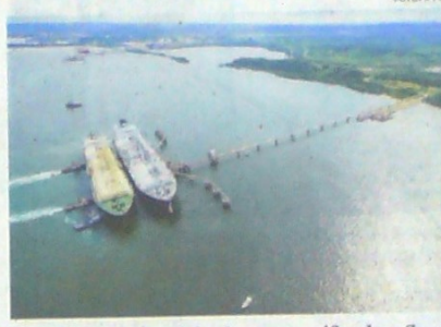
Vista panorámica de la planta regasificadora Spec.
