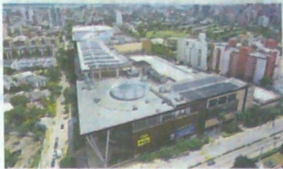
Paneles solares ubicados en el centro comercial.
