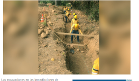
Las excavaciones en las inmediaciones de Terrotasajero comenzaron y según el contratista en noviembre empieza a llegar la tubería.
