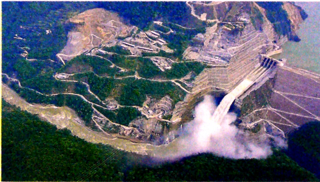
Aspectos de la represa de Hidroituango que sería la más grande del país cuando entre en operación. Archivo
