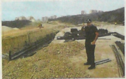
El alcalde Char inspeccionó las obras en la 43.
