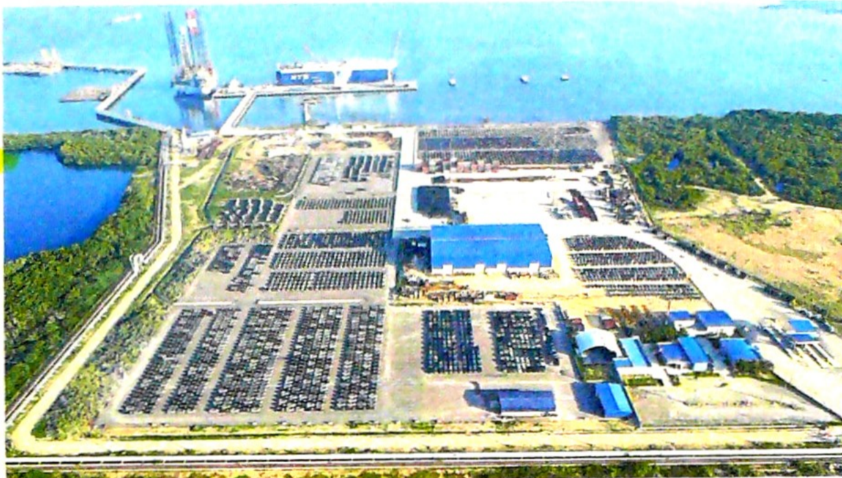
Actualmente el 80% de la carga que se mueve por el río Magdalena, llega por esta terminal. Cortesía: Puerto Bahía
