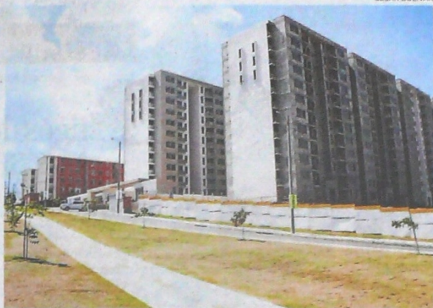
Proyecto de vivienda en construcción ubicado en la ciudad de Barranquilla.
