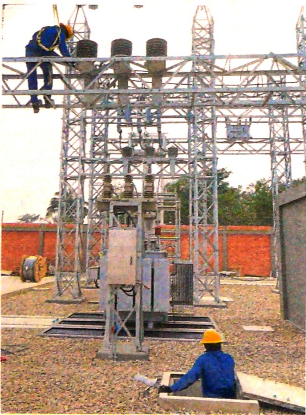
La obra trae la ampliación de subestación Urabá y Chinú. CEET
