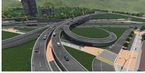
Avenida El Rincón, la obra que pretende descongestionar Suba.
